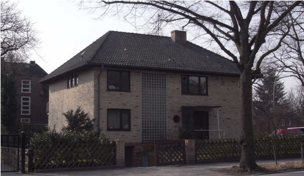
Vor der Aufstockung
