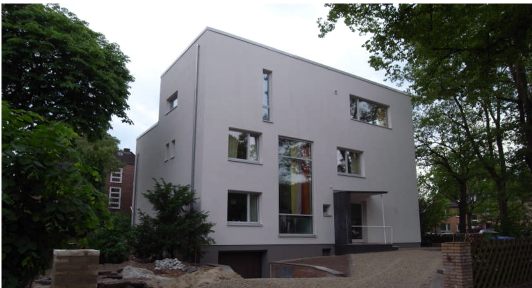
Nach der Aufstockung
